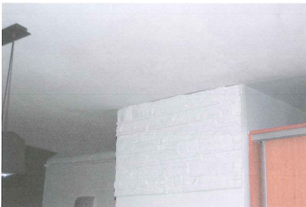
Fot. 6. Podsufitka stropowa, widoczne miejsce napraw.
