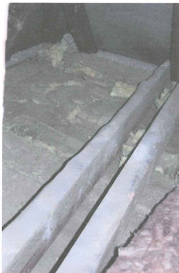
Fot. 5. Widok stropu na poziomie poddasza.
