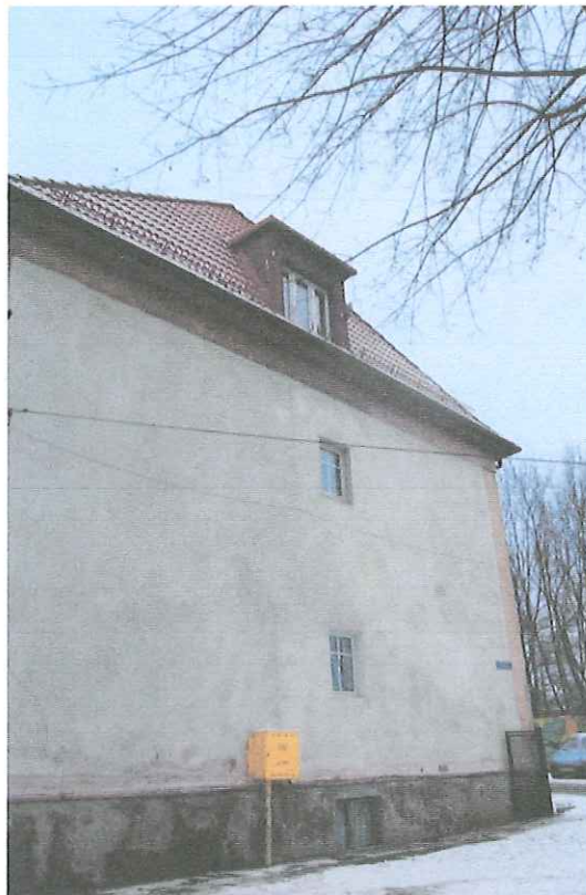
Fot. 2. Widok elewacji wschodniej.
