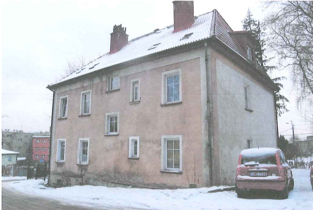
Fot. 1. Widok elewacji północnej.
