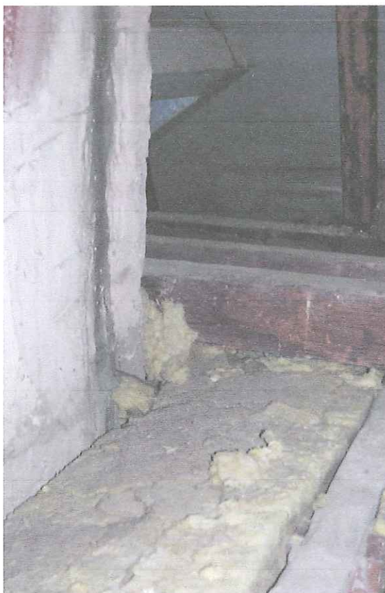
Fot. 4. Widok stropu na poziomie poddasza.
