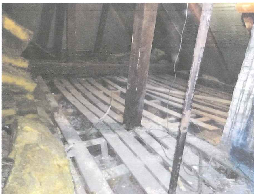
Fot. 3. Widok konstrukcji stropu na poziomie poddasza (fot. Domaro Sp. z o.o.).
